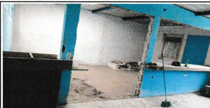
Foto1: Rehabilitación de paredes (cocina)
