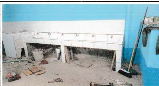
Foto 2: Sustitucion de azulejos y chorros en lavamanos
