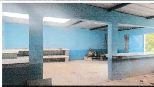
Foto 4: Susutitucion de piso ceramico en cocina
