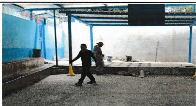
Foto 5: Sustitución de piso ceramico en escenario (corredor)
