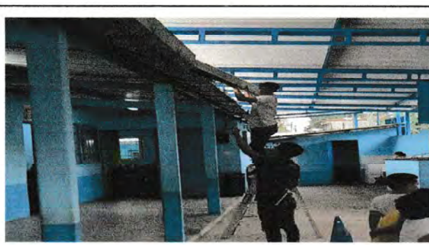
Foto 6: Sustitución de canales y bajadas de aguas pluviales
